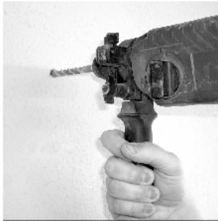
2. Löcher bohren ( $\varnothing$  10mm) und aussaugen
