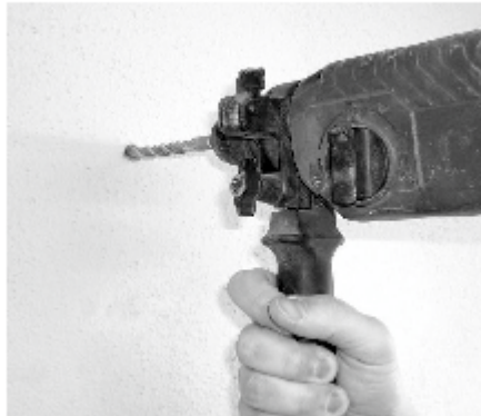
2. Löcher bohren ( \varnothing 10mm) und aussaugen
